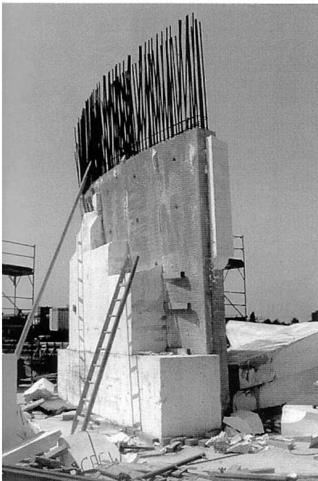
Von der Millimetergenauigkeit der Software aus dem Auto- und Flugzeugbau zur Baustelle: Die freie Form der aussteifenden Wand im Gebäude C entsteht mit Hilfe einer Polystyrolschalung.
